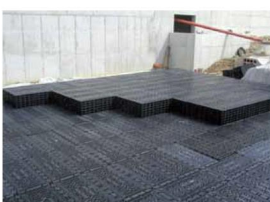
شکل ۶: مراحل اجرایی سیستم تونلی گراف
