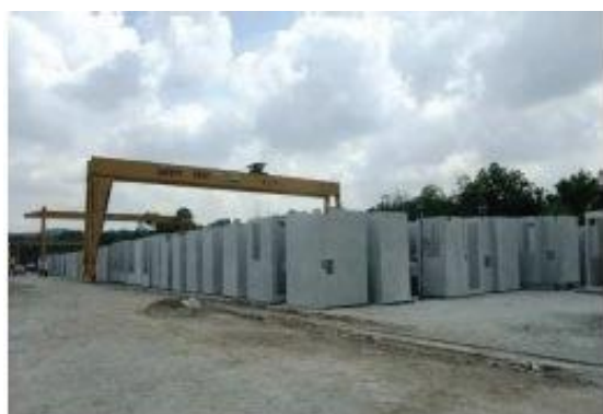
۲- آماده سازی و بهبود بتن و انبار کالا
