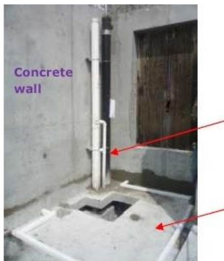
شکل ۲۸: محل قرار گیری داکت توالت
