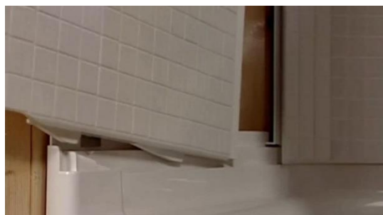
شکل ۷: نصب و راه اندازی عناصر پیش ساخته شده GRP، توسط KOHLER ساخته شده از قالب سازی فشرده تیپ SMC تولیدات VIKRELL
