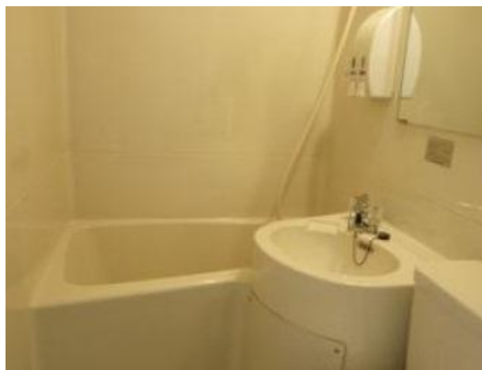
شکل ۱۶: حمام پیش ساخته ساخته شده از GRP، نصب در هتل KAZUSAYA، توکیو، ژاپن
