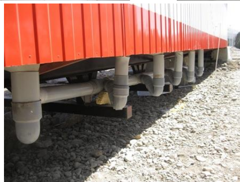
شکل ۳۳: مراحل ساخت کانکس سرویس بهداشتی
