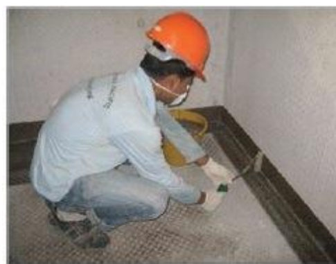
۳- پیاده کردن سیستم ضد آب برای دیوارها و
