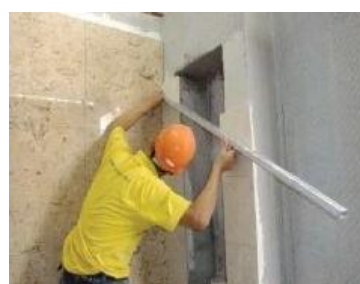
۵- اتمام نصب و اتصالات
