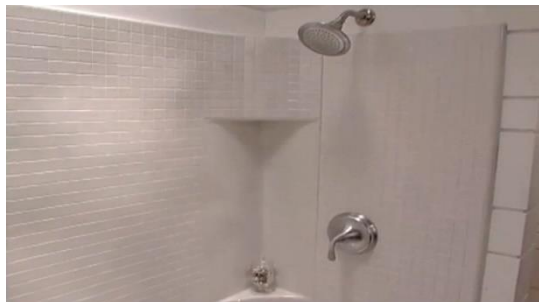
شکل ۷: نصب و راه اندازی عناصر پیش ساخته شده GRP، توسط KOHLER ساخته شده از قالب سازی فشرده تیپ SMC تولیدات VIKRELL
