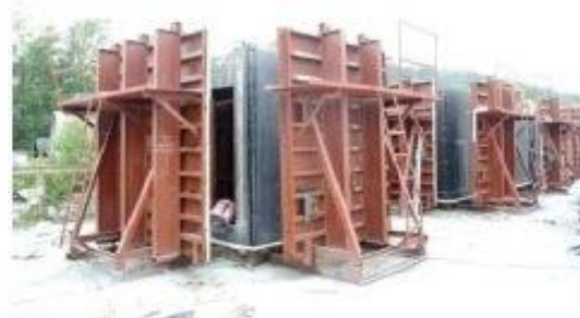
۱- قالب گیری پوسته بتن
