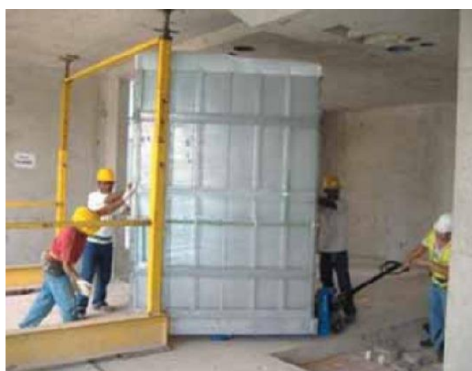
شکل ۲۴: جابه جایی واحد حمام پیش ساخته به موقعیت مورد نظر در ساخت و ساز
