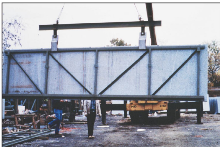
شکل ۴-۲۵- پانل دیواری پرده‌ای پیش‌ساخته سنگی
