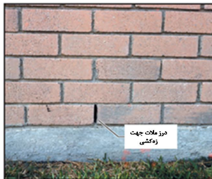
شکل ۵-۱۵- خالی گذاشتن درز ملات جهت زه کشی
