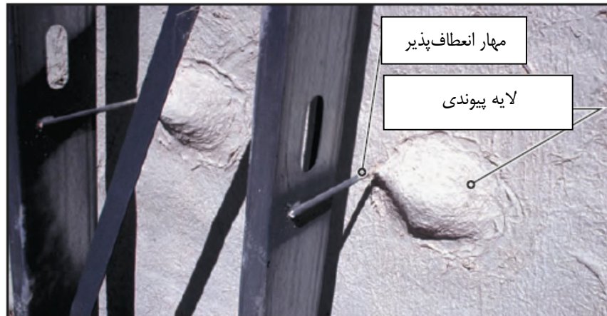
شکل ۶-۳۸- لایه پیوندی و مهارهای انعطاف‌پذیر
