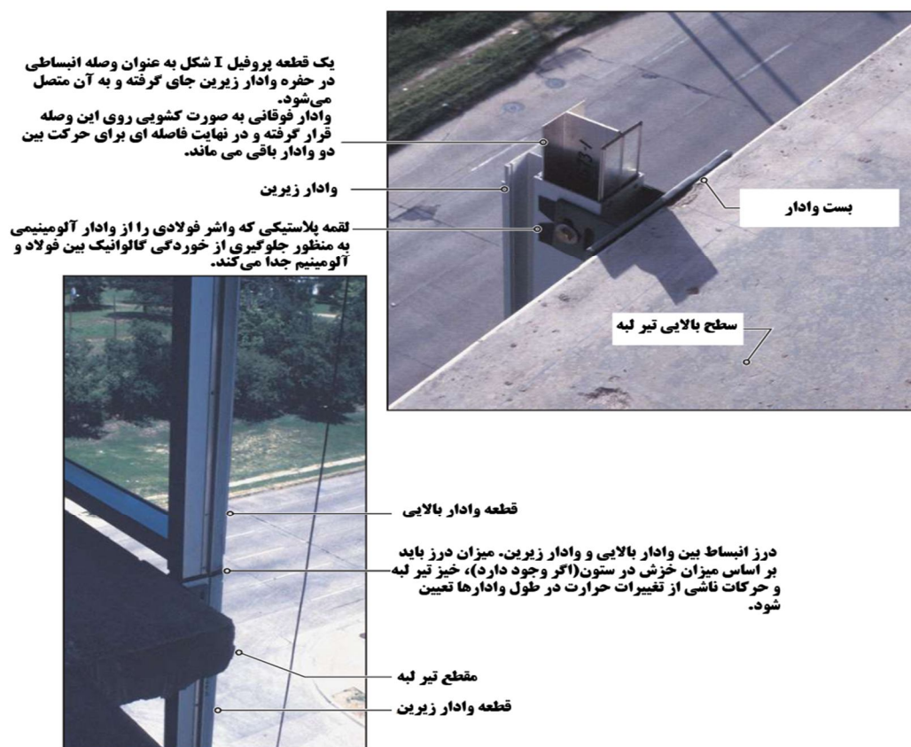
شکل ۸-۸- نمونه اتصال انبساطی بین دو قطعه وادار
