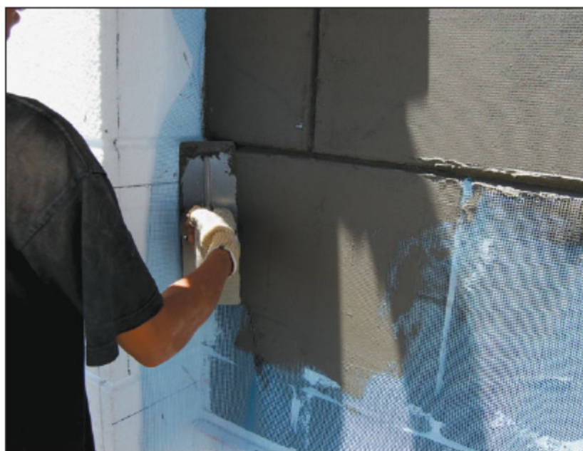
شکل ۶-۱۸- اجرای لایه‌های پوششی
