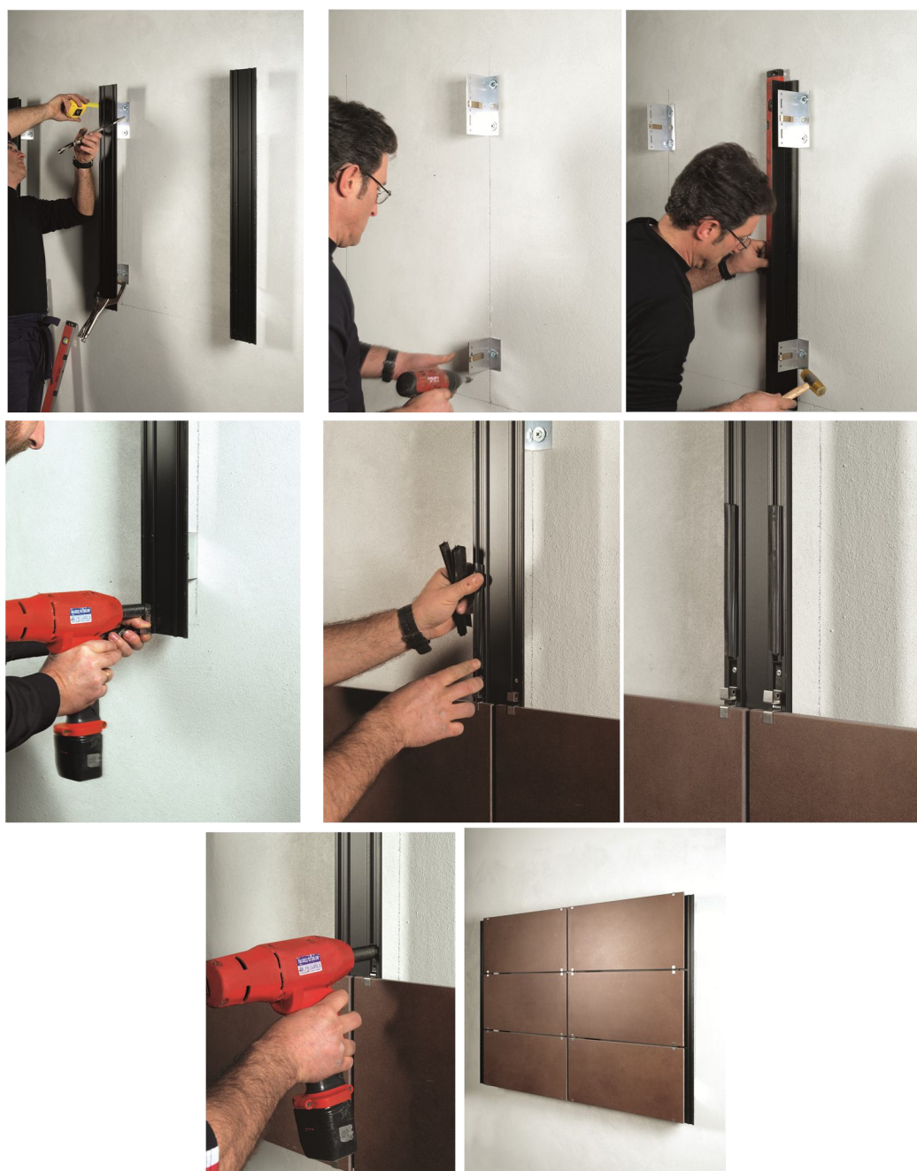
شکل ۷-۲۴- مراحل نصب سیستم نصب نمایان
