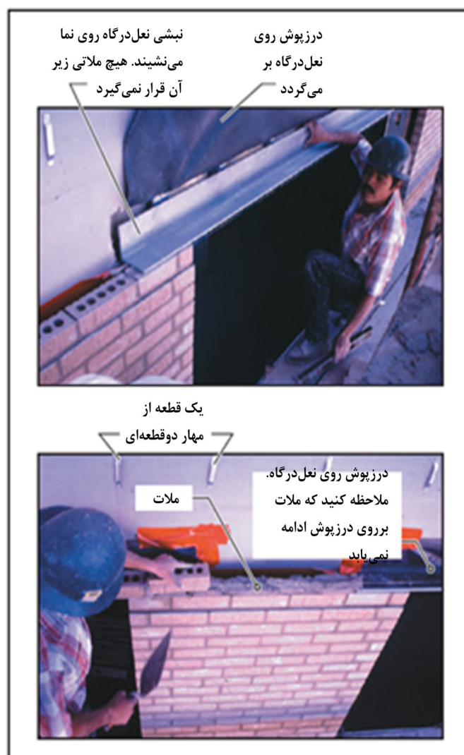
شکل ۵-۱۲- قرار گیری تیر نعل درگاهی در نمای آجری
