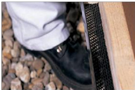
شکل ۶-۶۱- اجرای شبکه توری زیر دیوار
