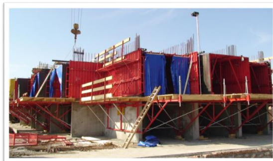
شکل ۱: سیستم ساخت تونلی - پروژه آذران تبریز (شرکت سرمایه گذاری مسکن آذربایجان)
