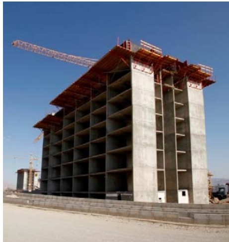
شکل ۱- سیستم ساخت قالب تونلی
